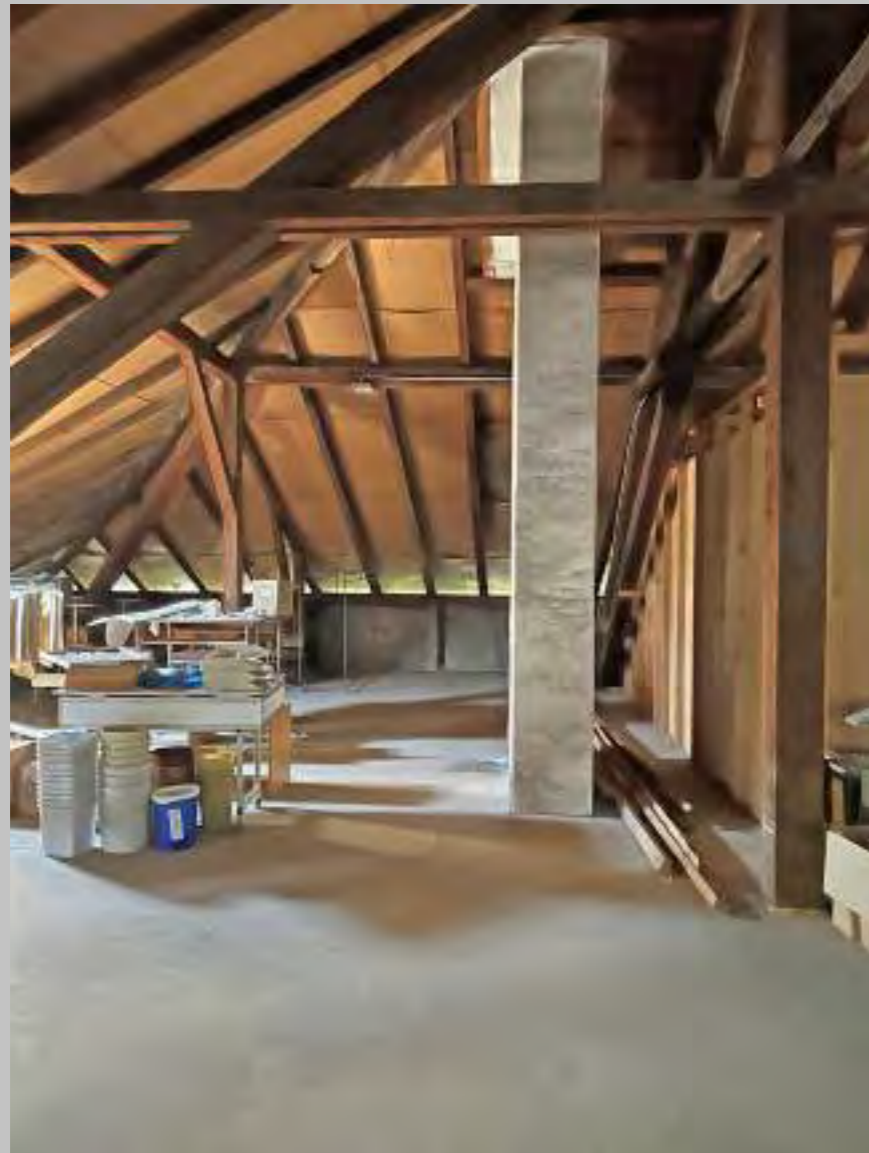
Bestehendes Dachgeschoss mit Potenzial
